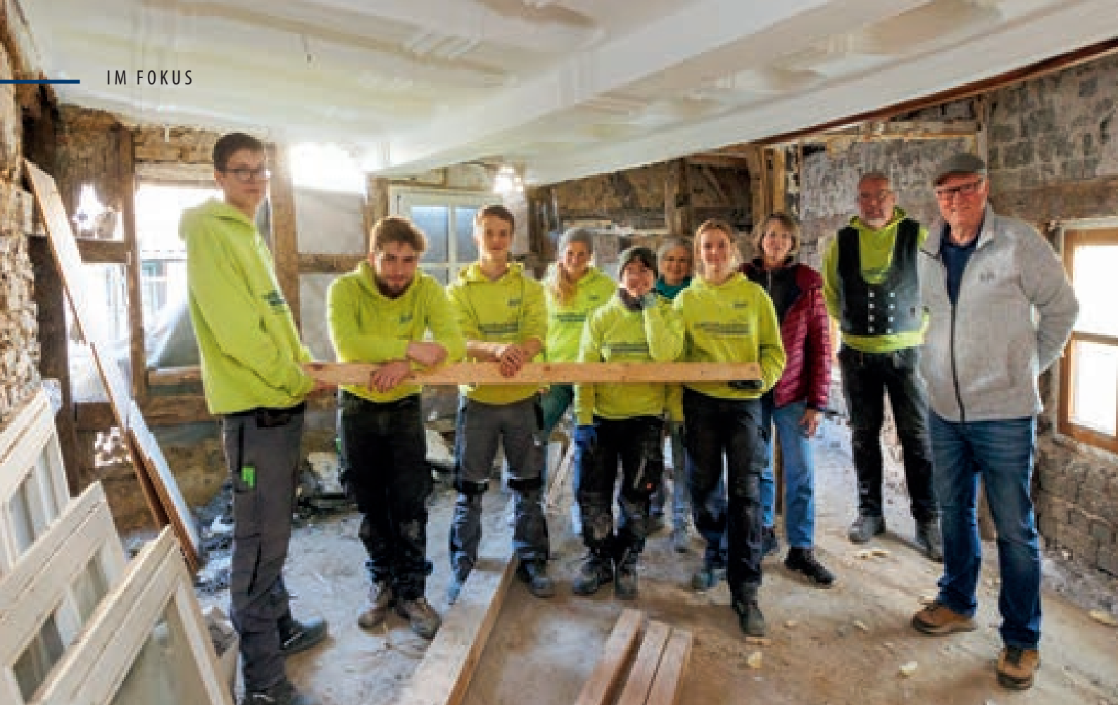
Das Mobile Team Fluthilfe der Jugendbauhütten packte bei der Instandsetzung der hochwassergeschädigten ehem. Synagoge in Dernau (RP) an.
