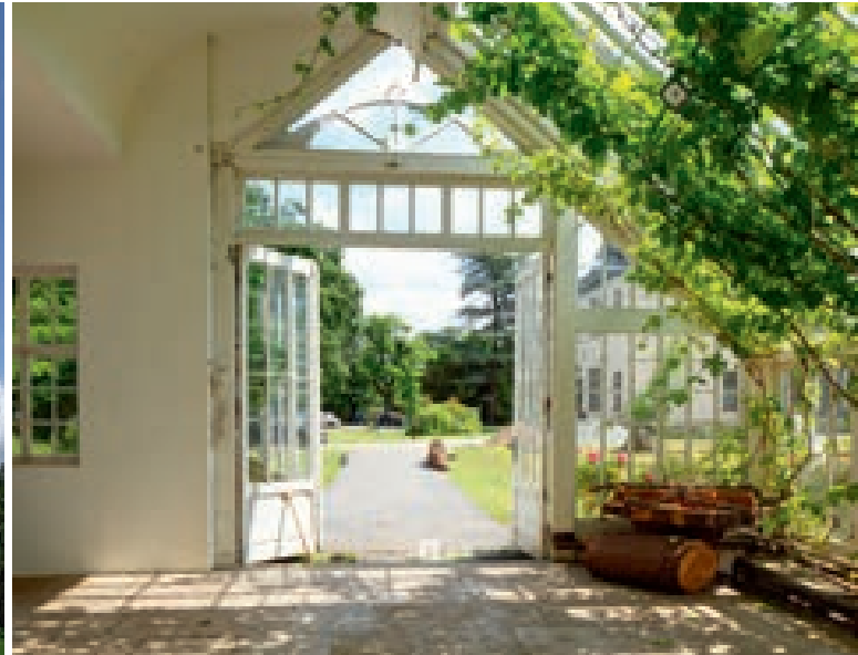
Die Deutsche Stiftung Denkmalschutz konnte 2022 dank Spenden und Geldauflagen beim Erhalt der Orangerie des Landguts Hasse in Bremen helfen.
