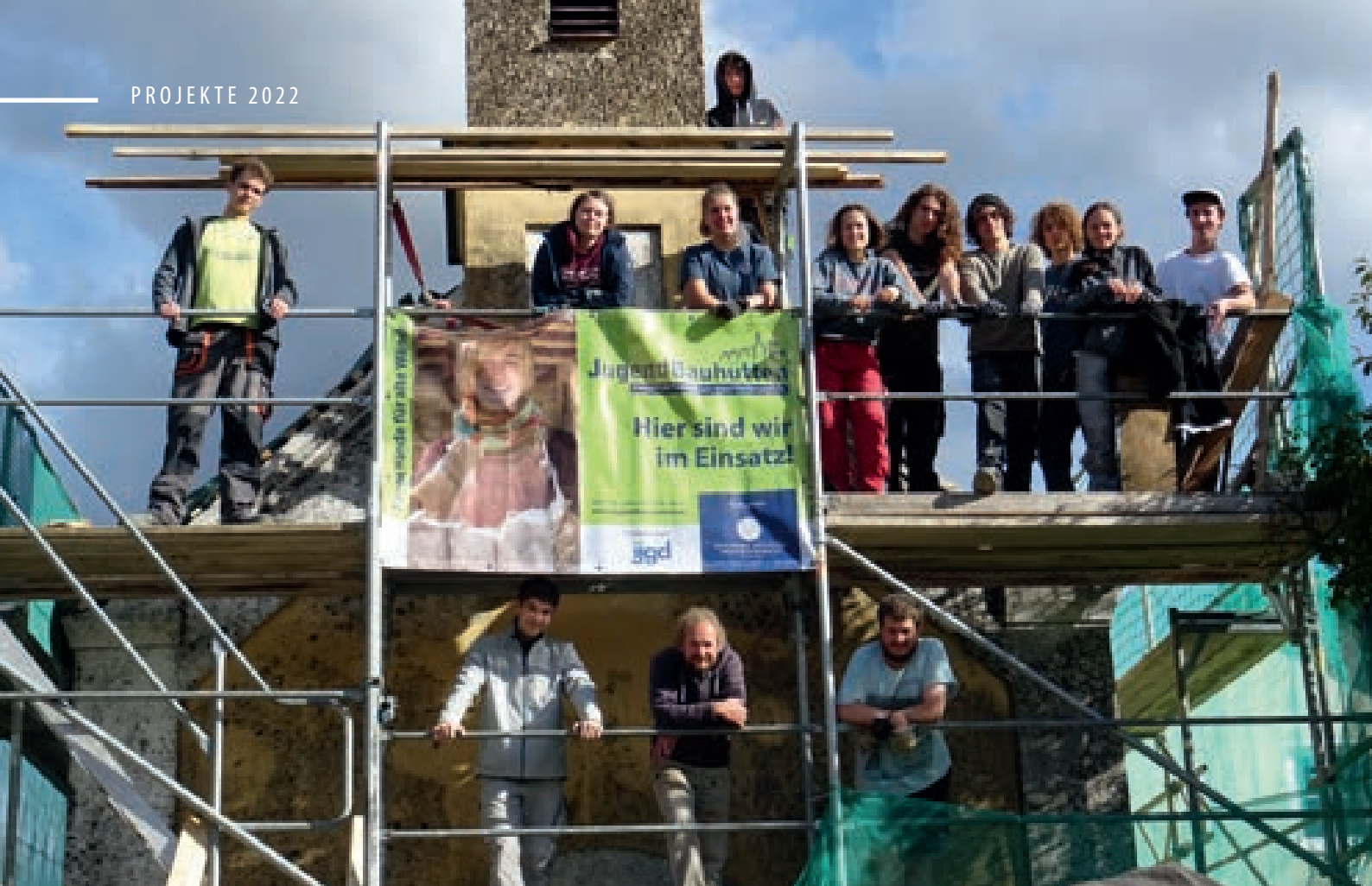
Die Jugendbauhütte Regensburg sanierte 2022 das Dach und den Putz der Kapelle in Anger (BY).
