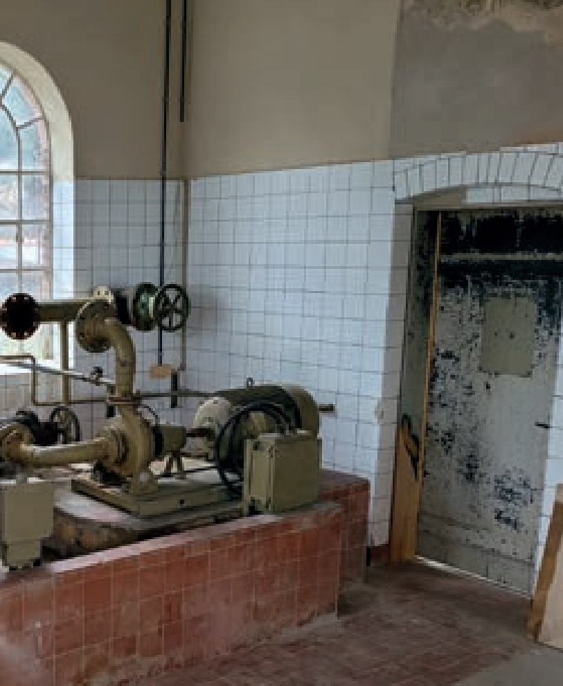
Rechts: Mit Hilfe der Deutschen Stiftung Denkmalschutz wurden die historischen Fenster auch energetisch ertüchtigt.
