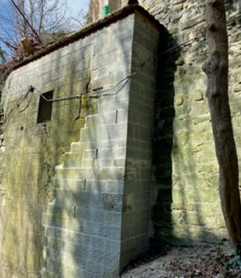
Zunächst musste 2022 ein maroder Mauerpfeiler an der Südfassade instandgesetzt werden.
