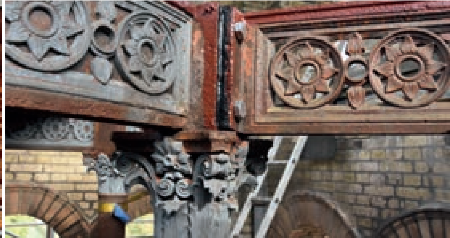
Die gusseiserne Konstruktion des Turms erfordert besonderes Know-how bei der Restaurierung.
